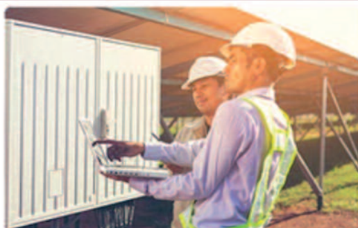
Riqualficazione energetica di impianti
