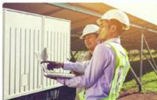
Riqualificazione energetica di impianti
