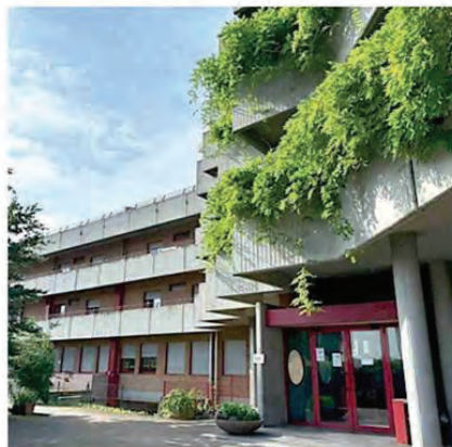
La Casa di comunità in via Botticelli a Torino
