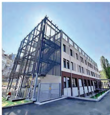
La struttura in corso Toscana a Torino
